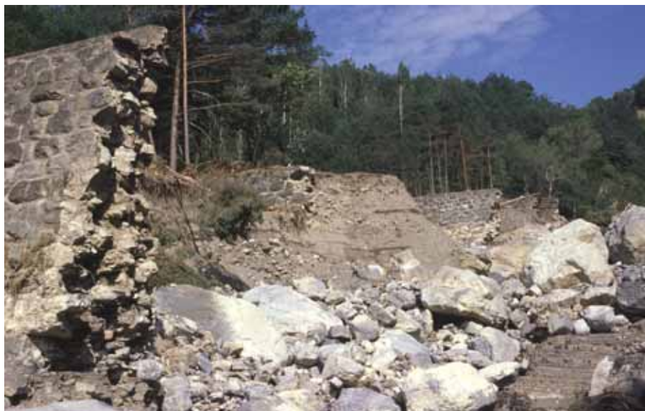
Fot. 2. Restos de presas de retención de sedimento, destruidas por la fuerza de la avenida, y bloques morrénicos.
